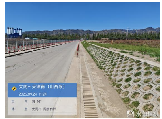
大同变电站进站道路空心六棱柱植草护坡
